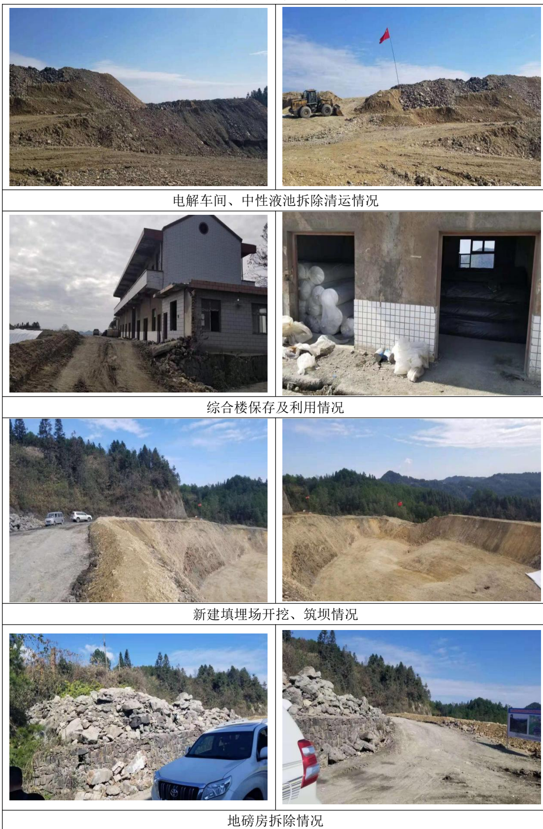
图 3.4-1 工程施工照片
