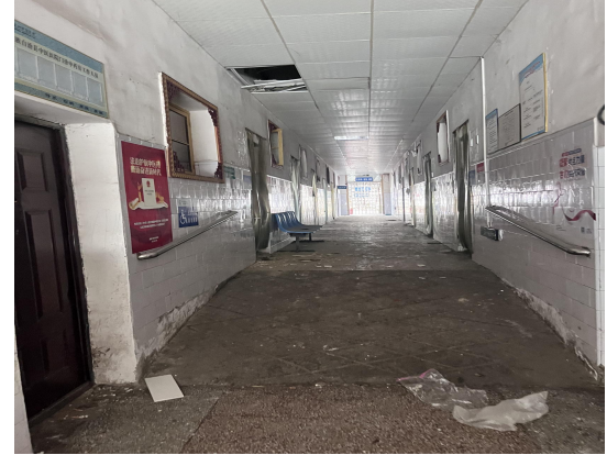
拟改造门诊楼内部情况
