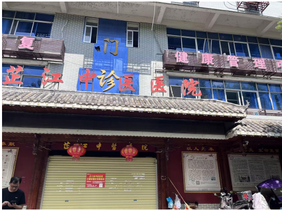
拟改造门诊楼现状
