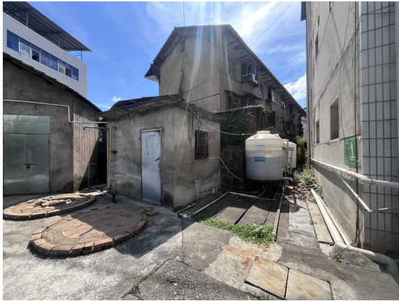
原中医院污水排放口
